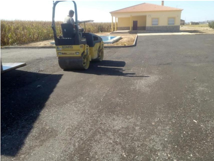
Ilustración 9. Aplicación de árido reciclado en una explanación.
